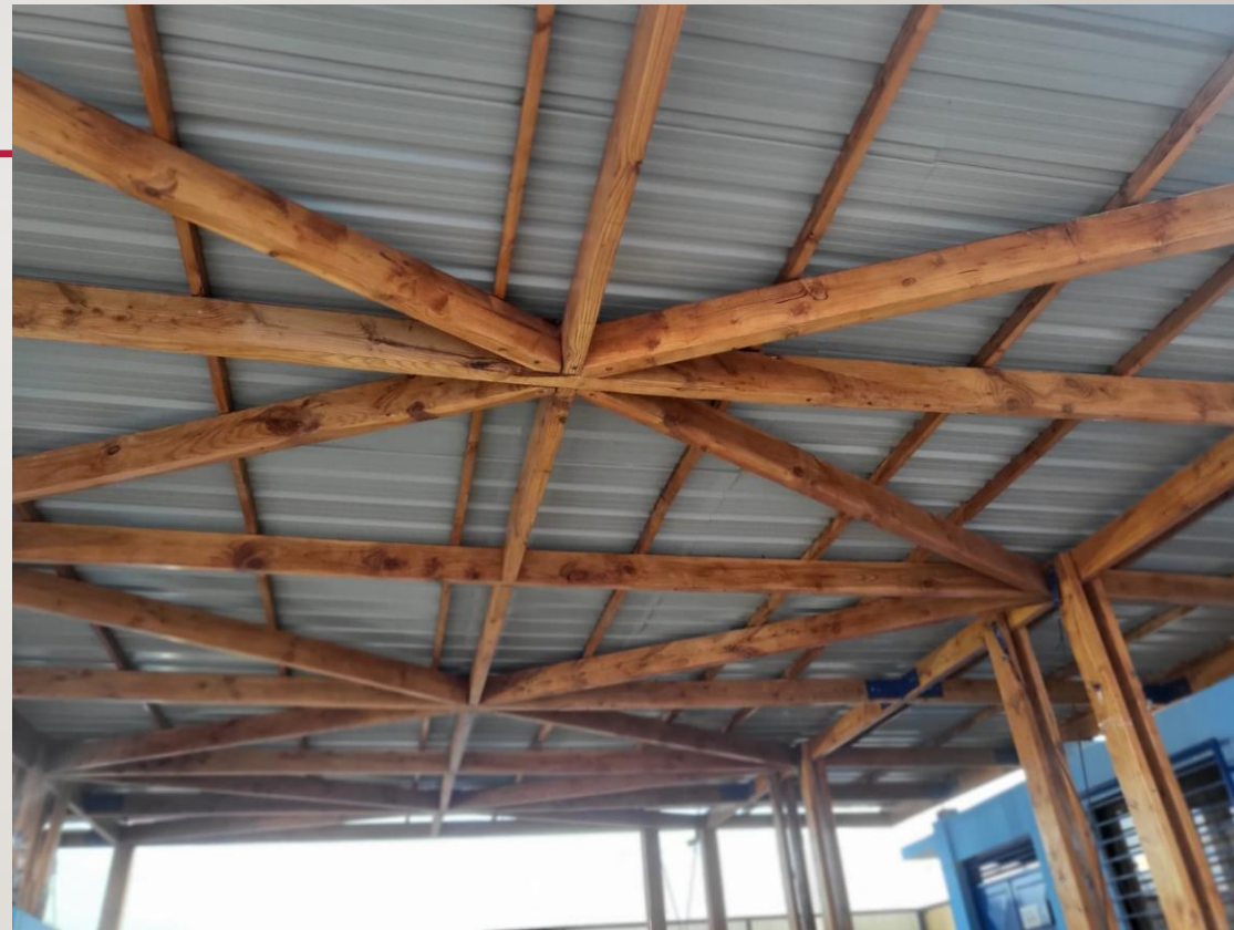
Reparación techo zona de boxes (Privado)
