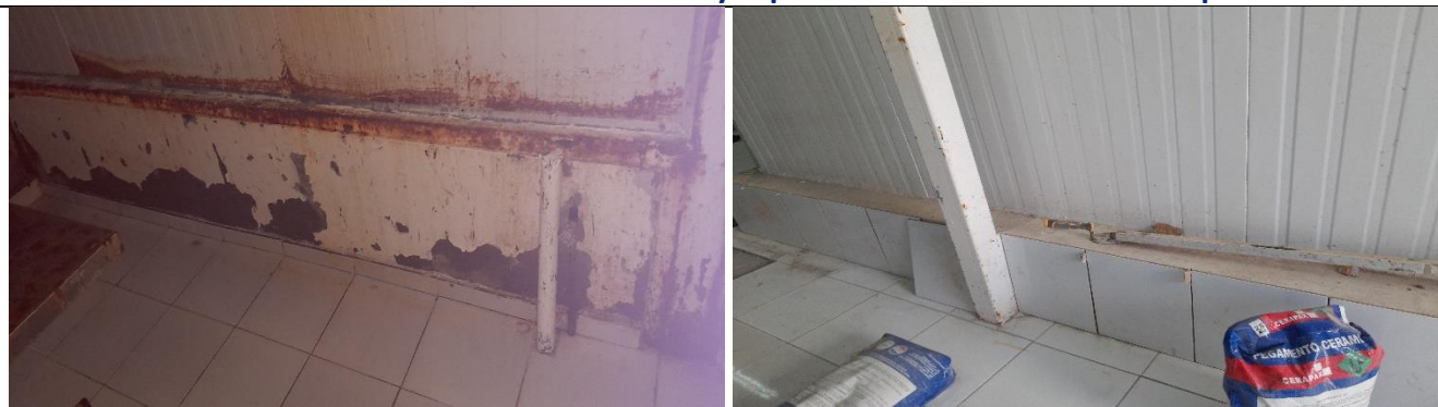
Instalación de cerámicos en muros y reposición de los dañados en el piso
