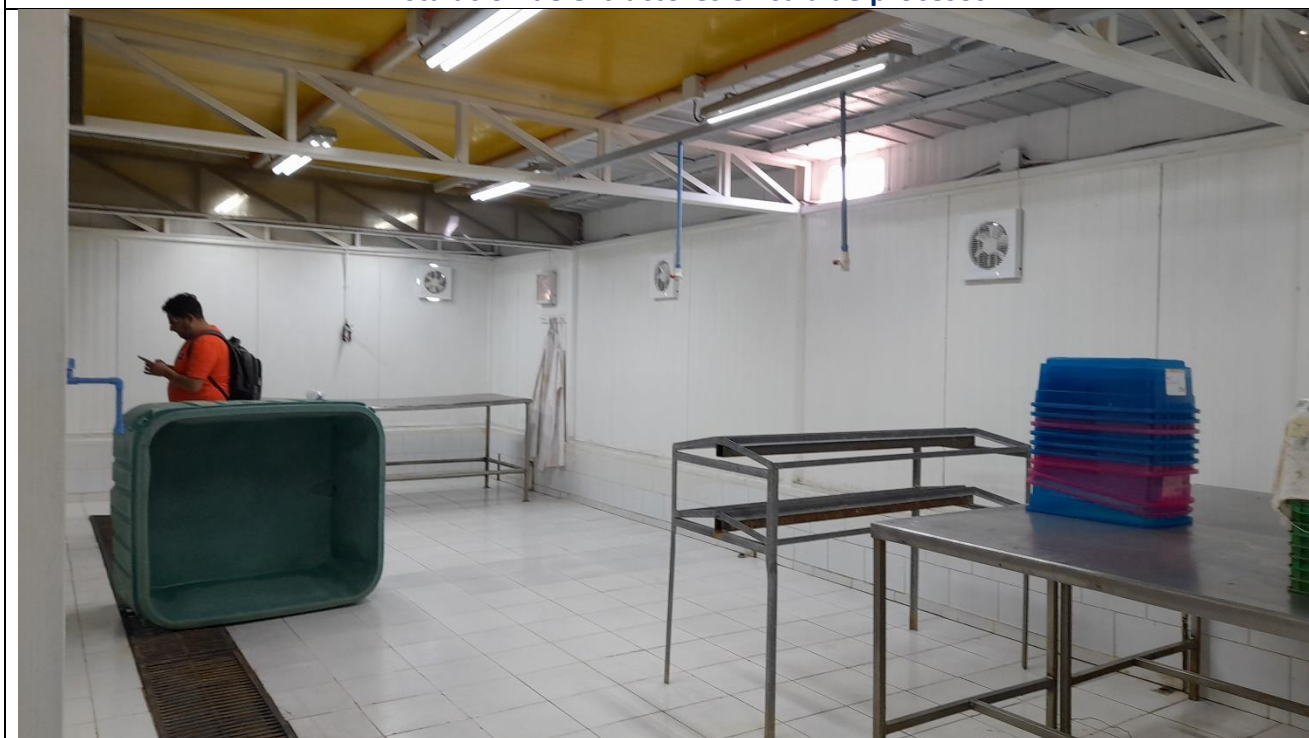
Instalación de extractores en sala de procesos
