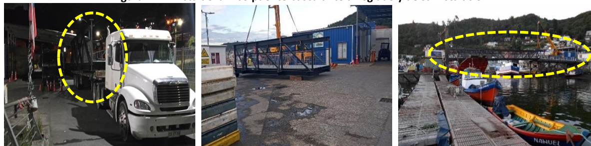
Figura N° 4: Vista del arribo puente basculante arreglado y de su instalación
