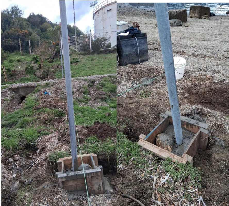
Figura 10 y 11. instalación de parantes para cierre perimetral.
