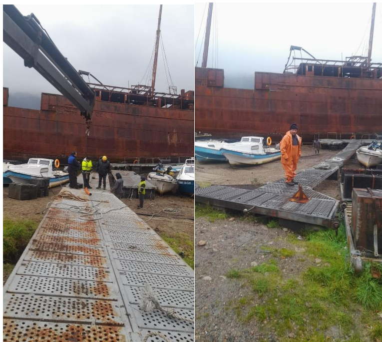
Figura 3 y 4. Instalación de pasillos
