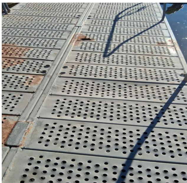
Figura 7. Pasillo de muelle flotante
