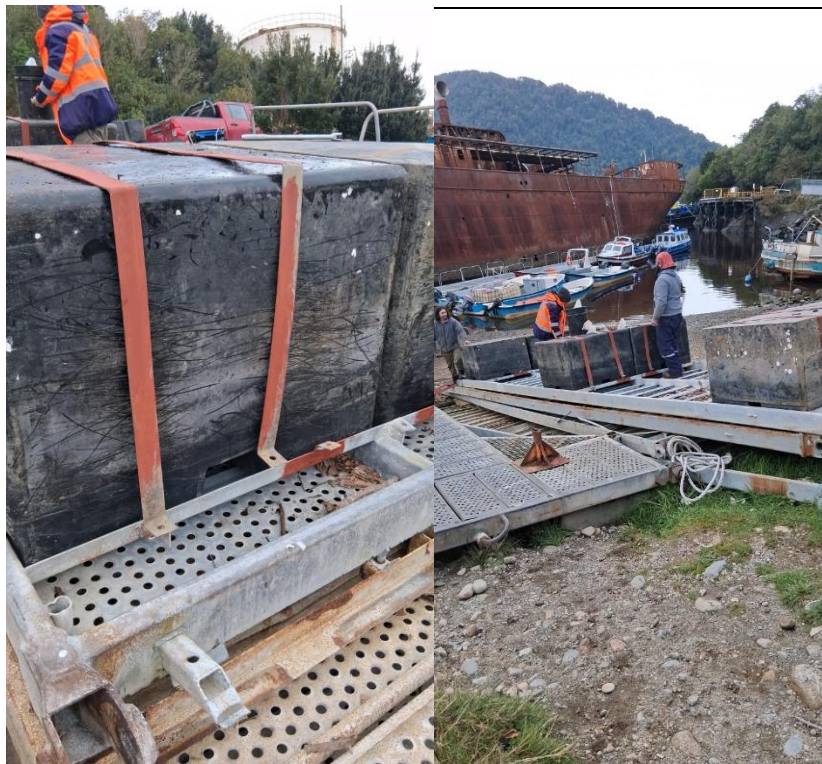
Figura 5 y 6. Instalación de flotadores
