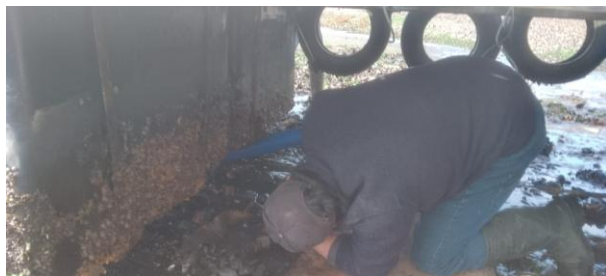
Figura N° 3: Reparación de amarres metálicos del flotador (“zuncho”)
