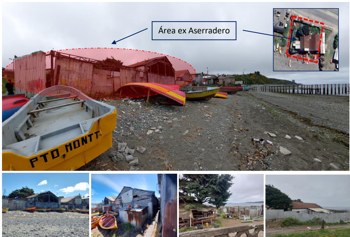
Figura N° 20: Área Galpones y terrenos en ocupación ilegal
