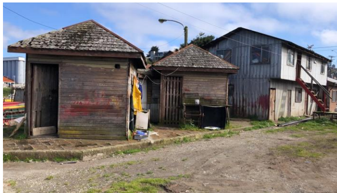
Figura N° 8 Vista uso de boxes
