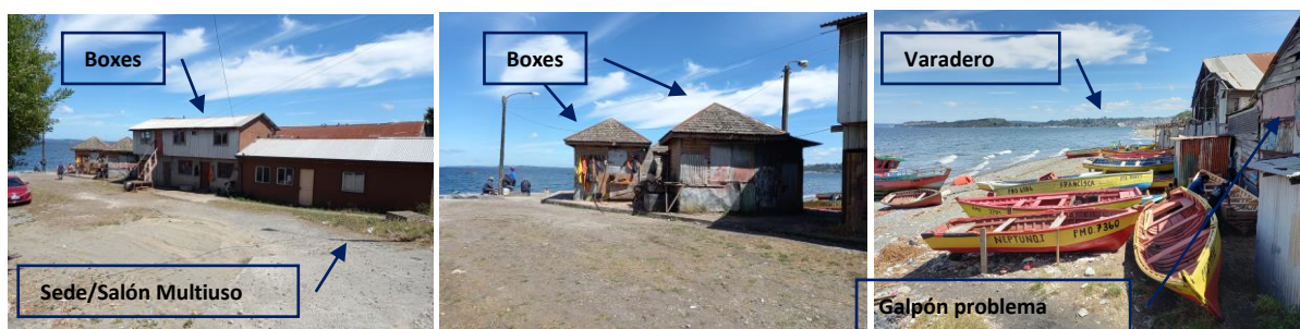
Figura N° 13 Vistas Sector Sede Social, Bodegas y varadero
