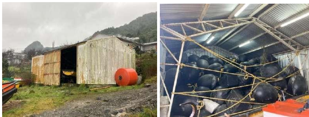
Figura N° 25: Vista exterior e interior de Galpón para resguardo de equipamiento y materiales.
