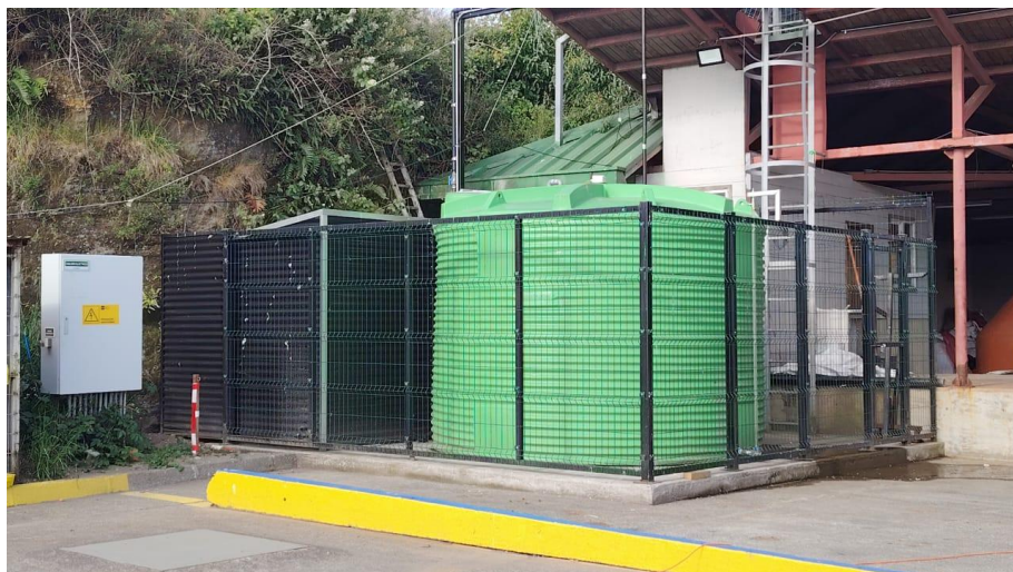
Estanque de Agua
