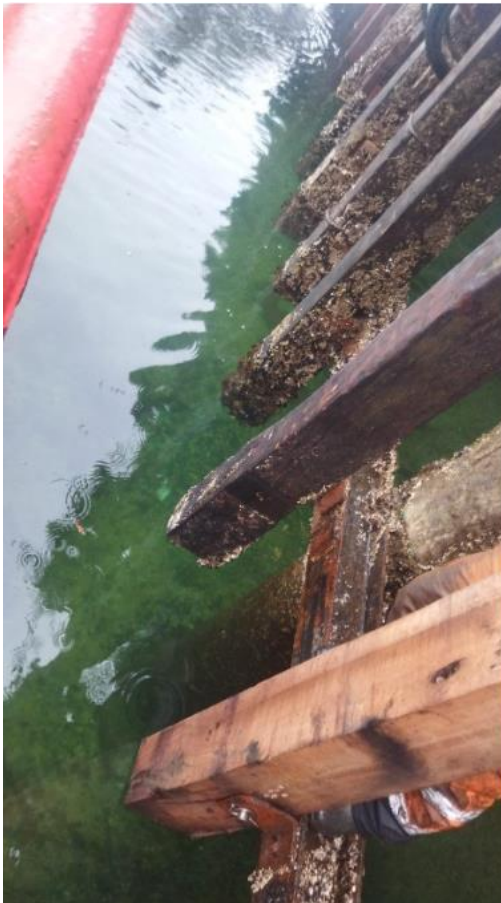
Figura1.- recambio de pilote en mal estado
