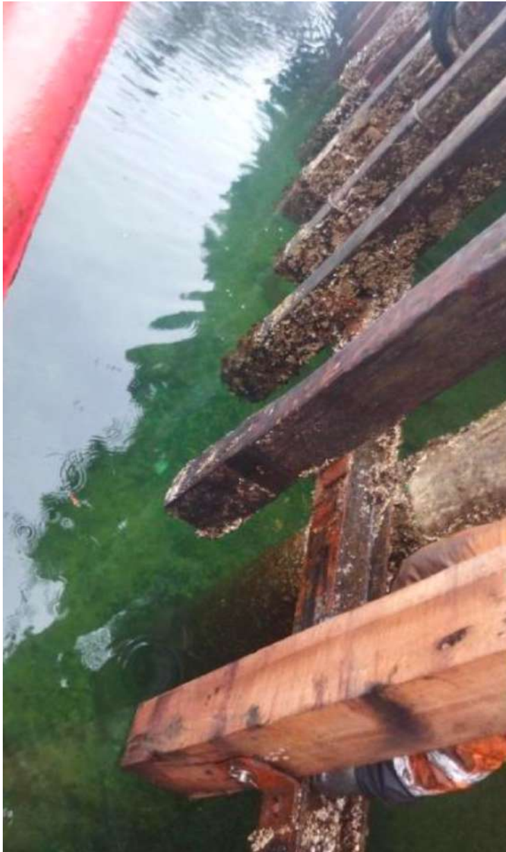
Figura N° 1, recambio de pilotes.
