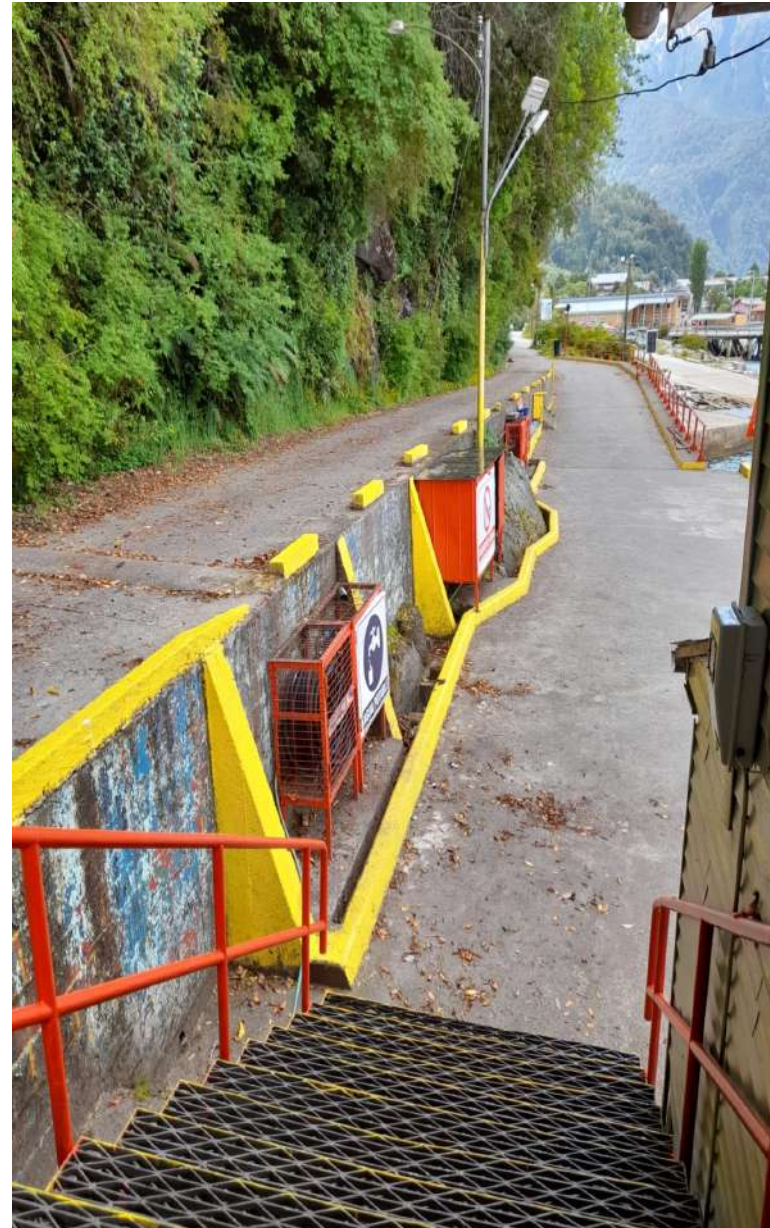
Figura N° 2, mantenimiento de pintura soleras.
