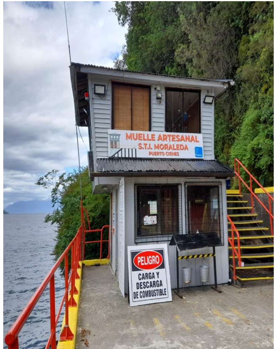
Figura N° 4, conservación y mantención caseta.
