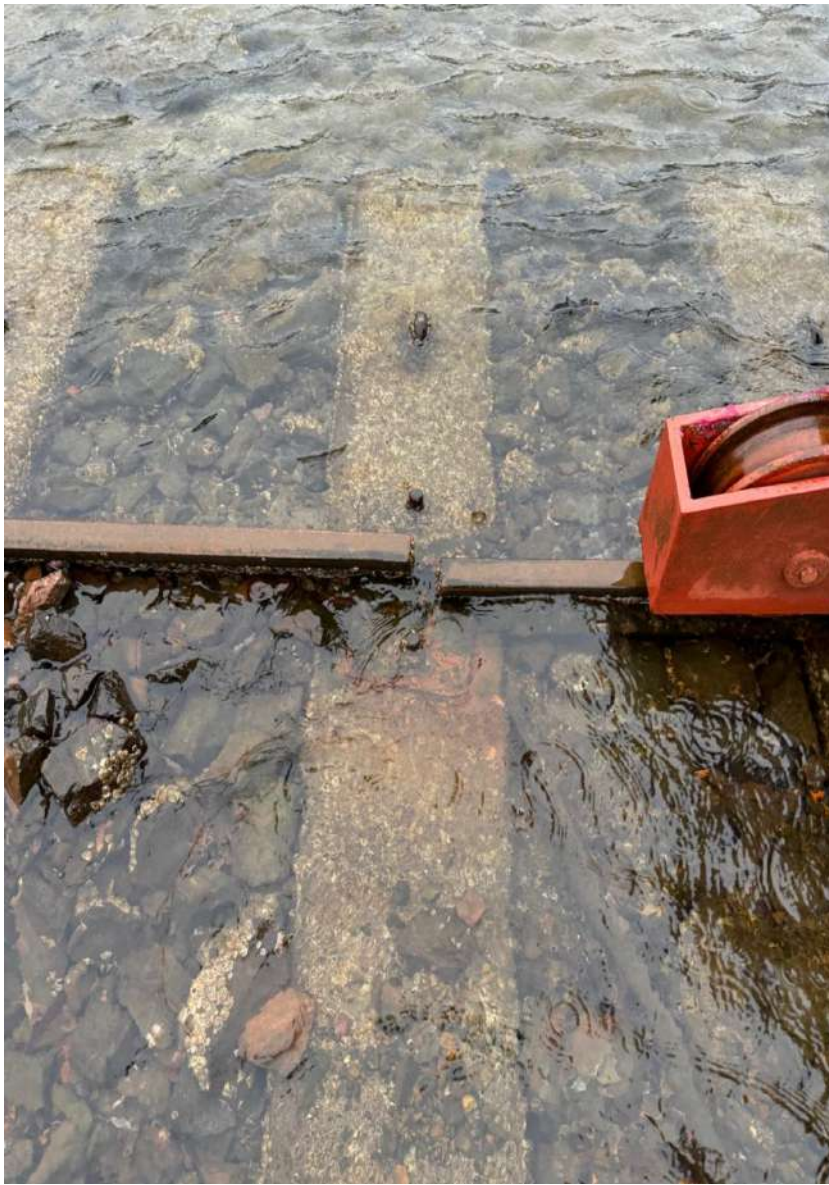
Figura N° 3 y N° 4: Rotura de rieles donde pasa el carro de arrastre.
