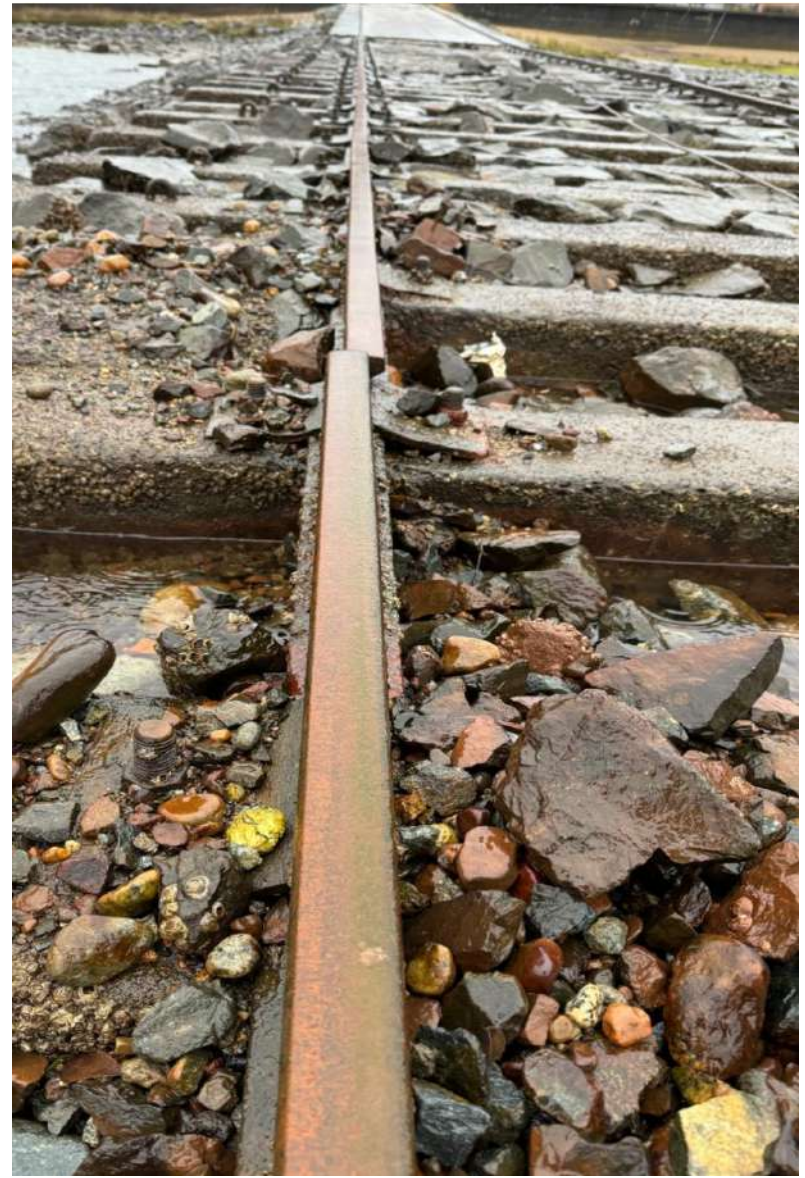
Figura N° 3 y N° 4: Rotura de rieles donde pasa el carro de arrastre.
