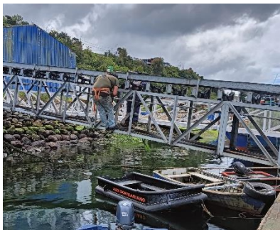
Figura N° 4: Vista operarios realizando mantención de la cinta transportadora
