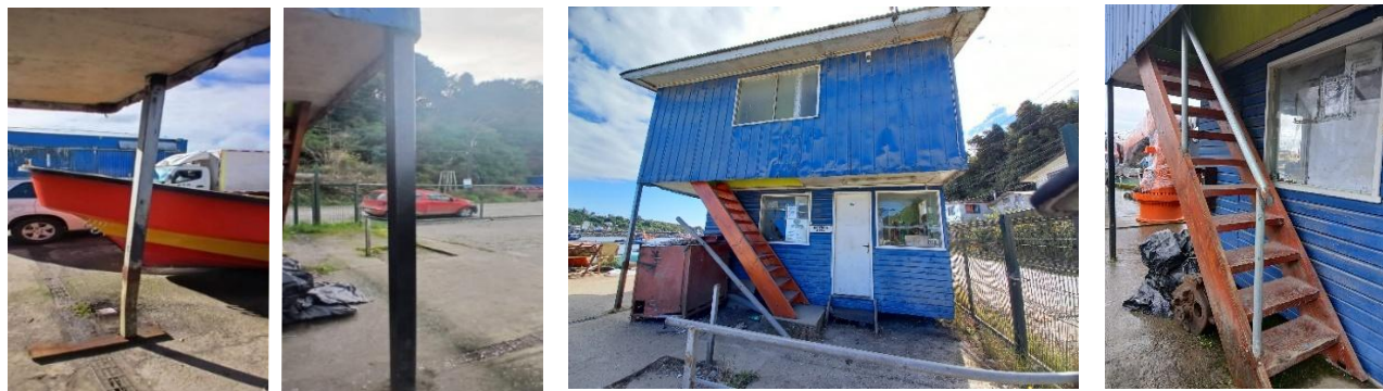
Figura N° 4: Cambio de pilar e instalación de pasamanos en escalera a oficina administrativa (antes y después).
